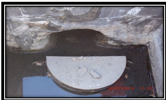
Loose Pollution Retardant Baffles
